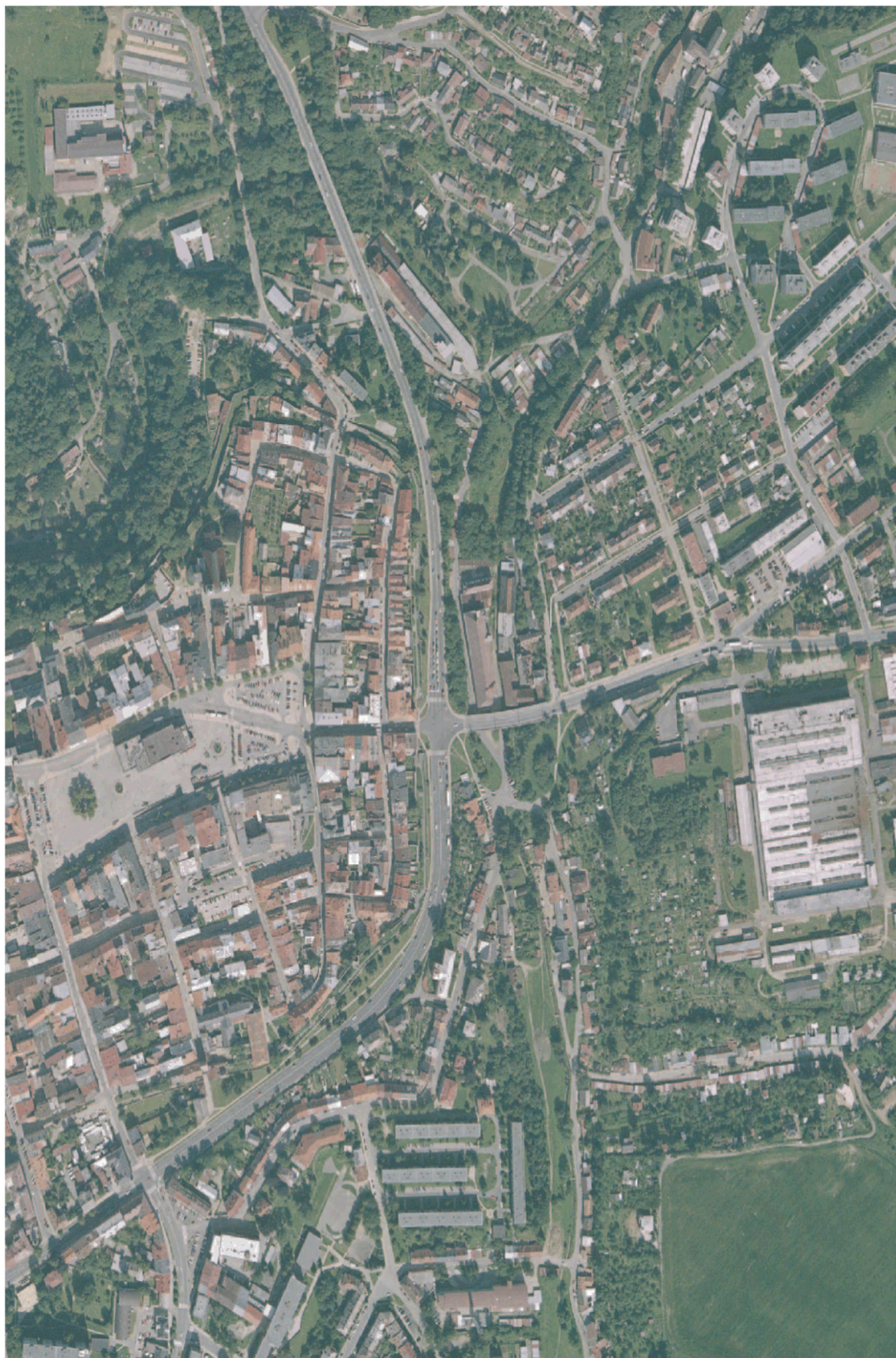
Letecký pohled na sídlo ERÚ - Jihlava
